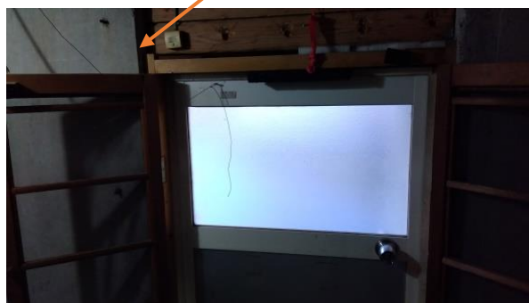
ドアに裏側上部に照明スイッチ
